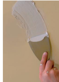
5. Enmasillado de las perforaciones
